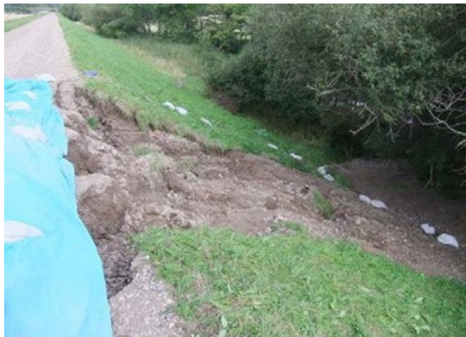
ຮູບທີ 48 ການເຊາະເຈື່ອນຕາມເປັນເນີນ ຂອງເຂື່ອນ
