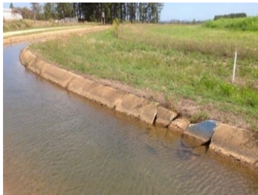
ຮູບທີ 66 ລະດັບ S-3: ຮອຍແຕກຂອງຄອນກຣີດຕາມຄອງສິ່ງນ້ຳ
