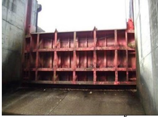
ຮູບທີ 59 ລະດັບ S-3: ປະຕູລະບາຍນໍ້າເປັນໜັງ
