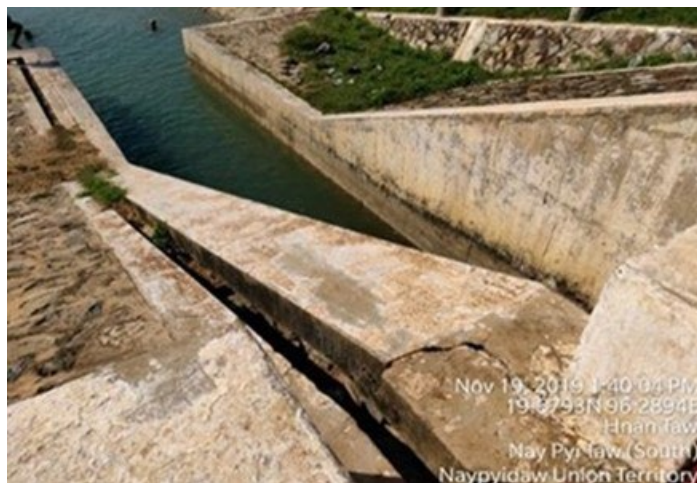
ຮູບທີ 52 ລະດັບ S-3: ຮອຍແຫງບໍລິເວນປະຕູລະບາຍນໍ້າລົ້ນ
