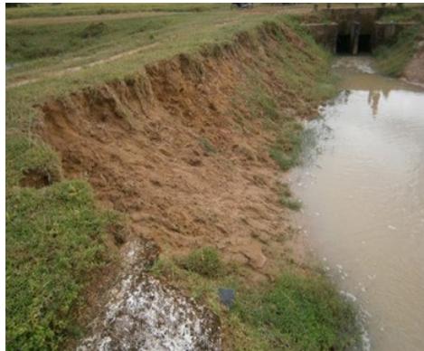
ຮູບທີ 64 ລະດັບ S-2: ການເຊາະເຈື່ອນຢ່າງຮຸນແຮງຂອງຄອງສິ່ງນໍ້າ
