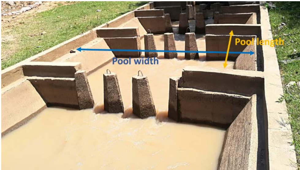
ภาพผนวกที่ 3.8 การวัดความยาวและความกว้างของห้องน้ำ
