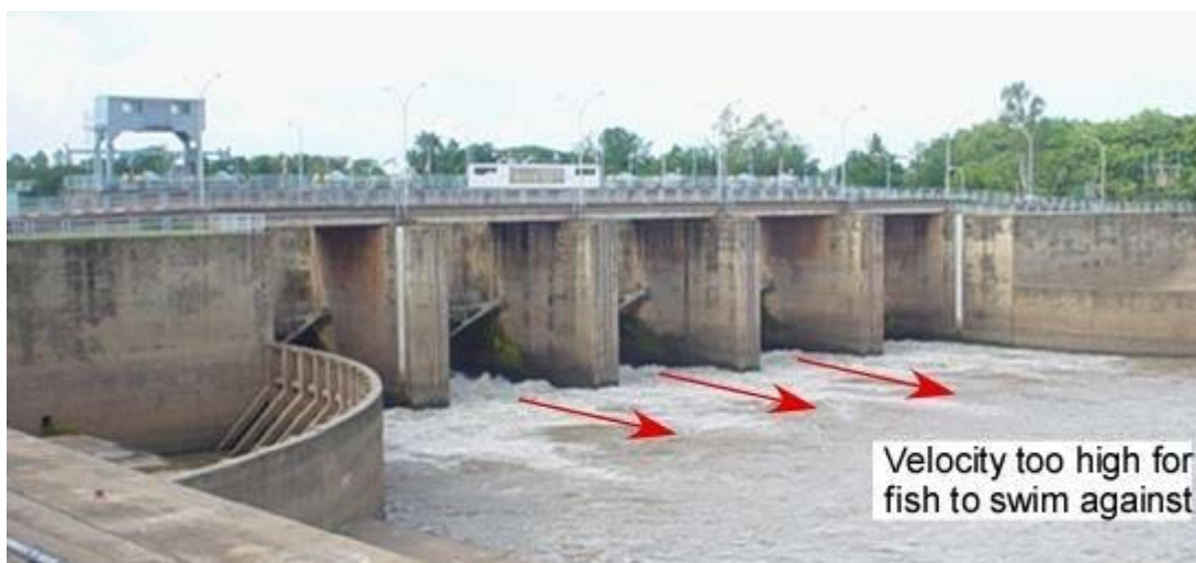
ภาพผนวกที่ 1.3 ฝ่ายที่มีบานประตูแบบบานโค้ง ที่ตั้งอยู่บนแม่น้ำสายหลักก่อให้เกิดการไหลของน้ำแรง ทำให้ปลาไม่สามารถว่ายน้ำต้านกระแสน้ำได้
