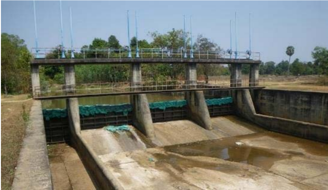
ภาพผนวกที่ 1.4 ฝ่ายแบบมีประตูระบายน้ำที่ติดตั้งบนแม่น้ำสาขาสายเล็กใกล้แขวงสะหวันนะเขต ประเทศลาว เขื่อน (Dams)
