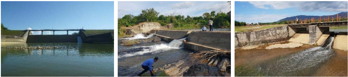
ภาพที่ 14 อาคารบังคับน้ำสูง \geq 4 เมตร (ซ้าย) ฝายที่มีความสูงระหว่าง 2-4 เมตร (กลาง) และฝายที่มีความสูงระหว่าง 1-2 เมตร (ขวา)
