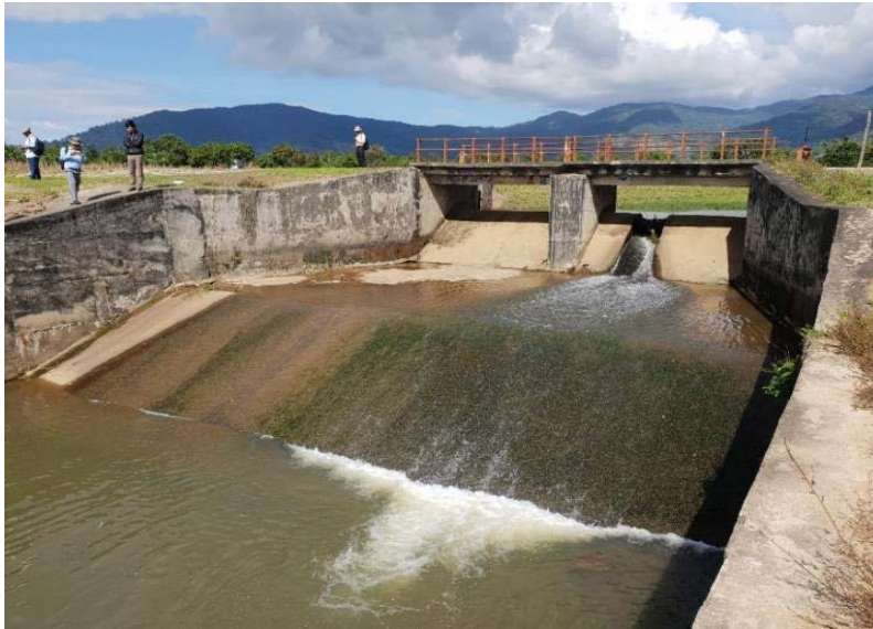
ภาพผนวกที่ 3.5 ปริมาณการไหลของน้ำที่มีน้อยซึ่งพบบริเวณฝายในช่วงตอนปลายฤดูฝน
