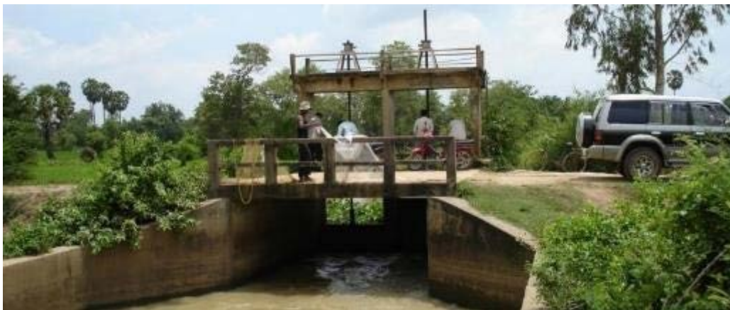
ภาพผนวกที่ 1.8 อาคารบังคับน้ำแบบประตูเหล็กที่ใช้สำหรับบังคับน้ำจากบริเวณพื้นที่ชุ่มน้ำที่ติดตั้งบริเวณทางข้ามลำน้ำ
