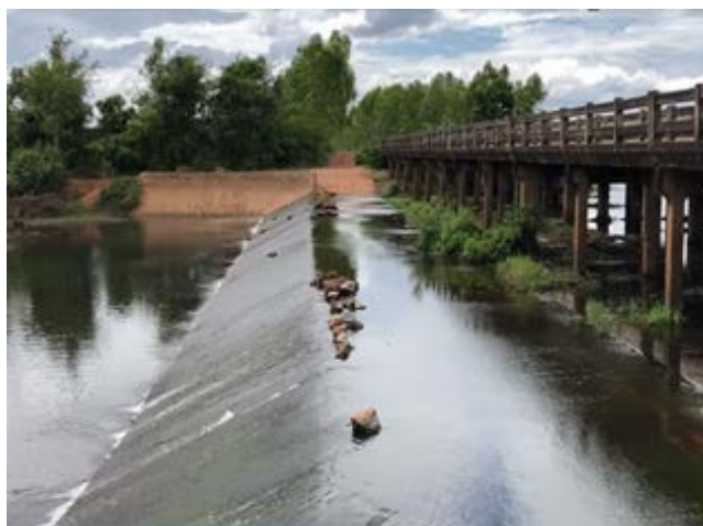
ภาพผนวกที่ 1.10 สะพานข้ามลำน้ำที่มีฝายน้ำล้น
