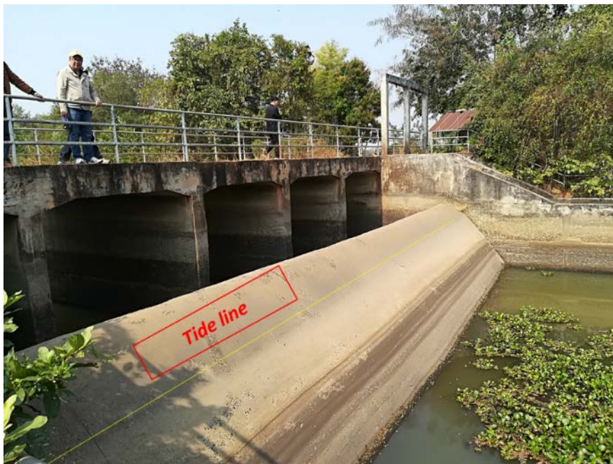
ภาพผนวกที่ 3.3 เส้นระดับน้ำขึ้นน้ำลงที่ปรากฏบนฝาย
