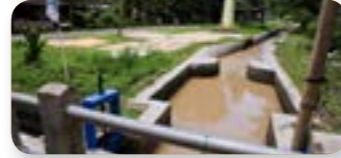
ទំនប់នេះ បានធ្វើឱ្យកសិករក្នុងតំបន់នោះមានភាពប្រសើរឡើង តាមរយៈការផ្តល់ទឹកដល់ប្រព័ន្ធស្រោចស្រពចំនួនបីគ្របដណ្តប់លើផ្ទៃដីជាង ៧០០០ ហិចតា។ ទំនប់នេះបានផ្តល់អត្ថប្រយោជន៍ដល់ប្រជាជនជាង ១៨ ០០០ គ្រួសារ។
